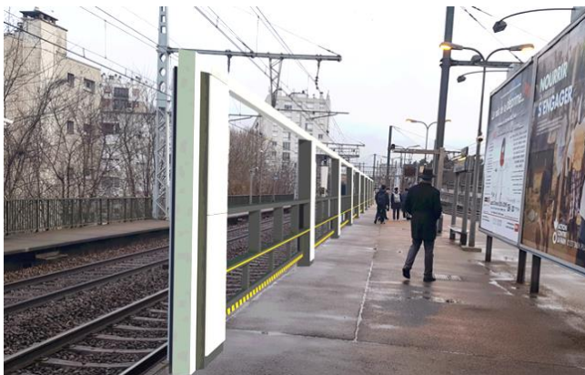
7 portes palières de 8m de longueur et 1,6m de largeur, avec des parois de verre pour sécuriser les quais de la gare. ©SNCF
