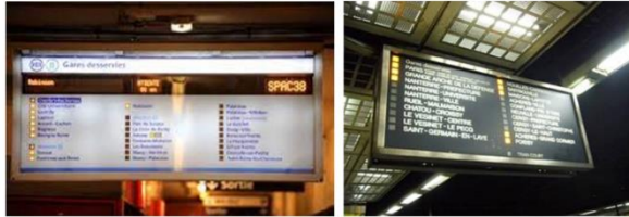
Figure 1 - Équipements actuels sur les quais du RER B (Panneaux Indicateurs de Direction dits PID)
